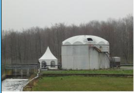
Bild 1: Versuchstropfkörper im Klärwerk Karlsruhe
